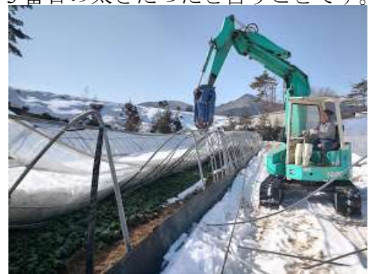
パイプを重機で引き抜く 84歳の父
