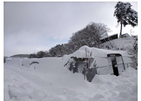
倒壊したビニールハウス
